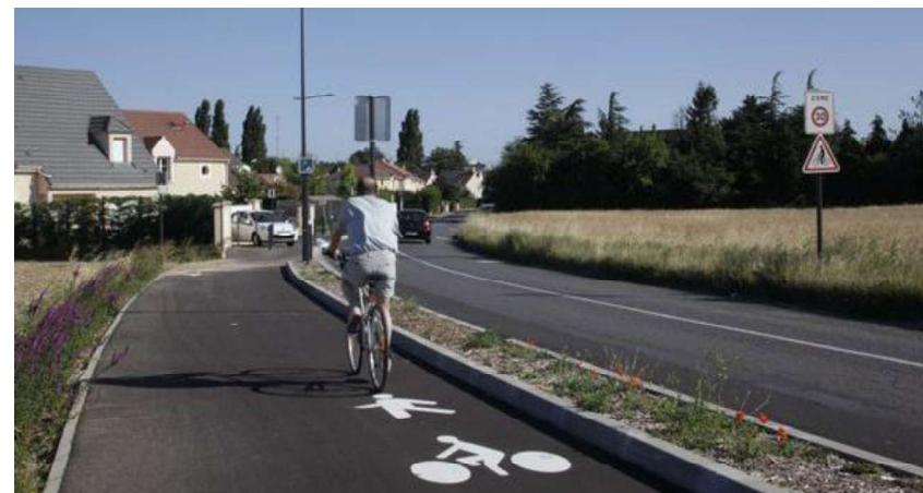
Exemple d'aménagements cyclables à Ballainvilliers (91) – Source : paris-sud-amenagement.fr
