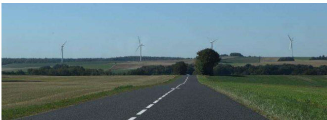
Eoliennes sur le territoire de la Communauté de Communes de Joinville (Source : Even Conseil)
