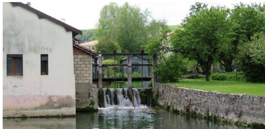
Artificialisation du cours d'eau – Courcelles-sur-Blaise (source : Even conseil)
