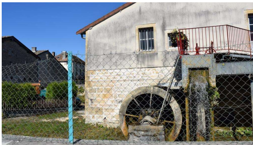
Un patrimoine hydraulique important sur le territoire (source : Even conseil)
