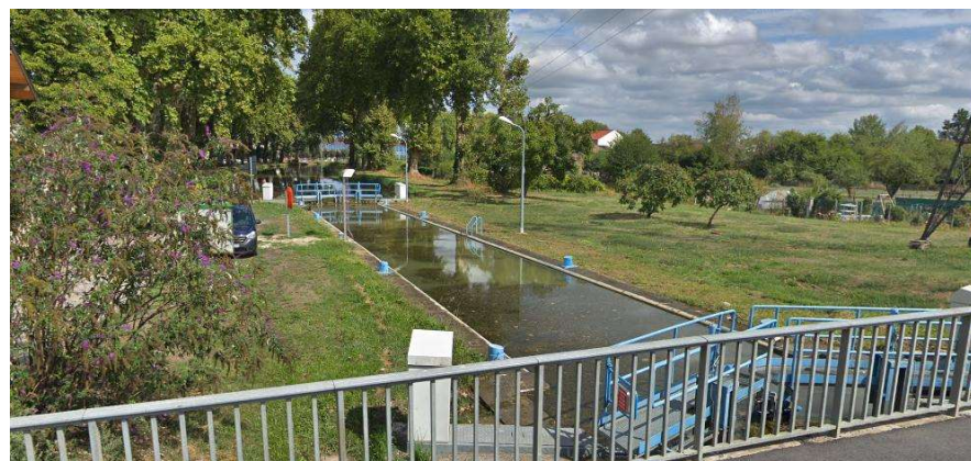
La double écluse de la Noue sur le canal de la Champagne à la Bourgogne – Saint-Dizier (source : Google Streetview)
