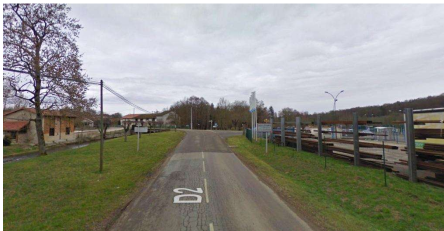
L'entrée ouest de Perthes, dégradée par des espaces de stockage de matériaux et des dépôts sauvages (source : Google Streetview)
