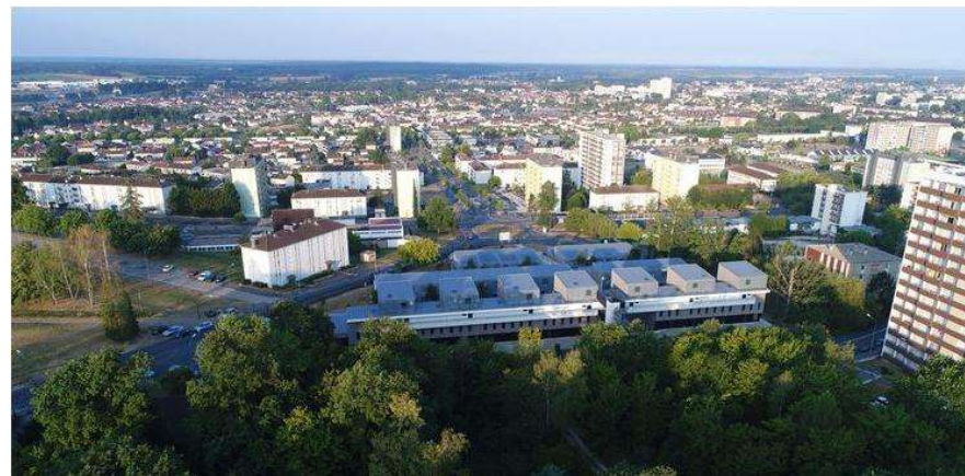
Panorama sur le quartier du Vert-Bois à Saint-Dizier (source : Ville de Saint-Dizier)
