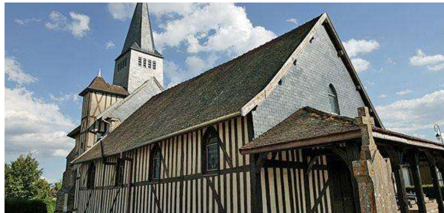
Un bâti traditionnel marqué par le bois (source : Office du Tourisme de Haute-Marne)
