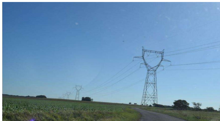
Des lignes à haute-tension particulièrement perceptibles depuis les milieux ouverts (source : Even conseil)
