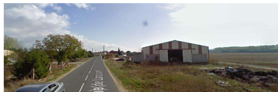
L'entrée ouest de Perthes, dégradée par des espaces de stockage de matériaux et des dépôts sauvages (source : Google Streetview)
