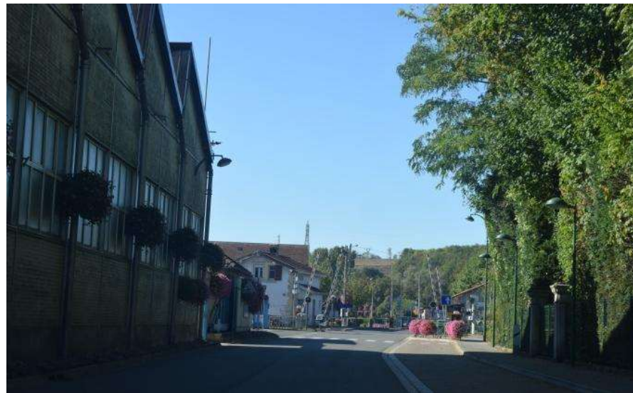
Un patrimoine industriel témoin de l'activité passée du territoire présent sur l'ensemble du périmètre de projet (source : Even conseil)
